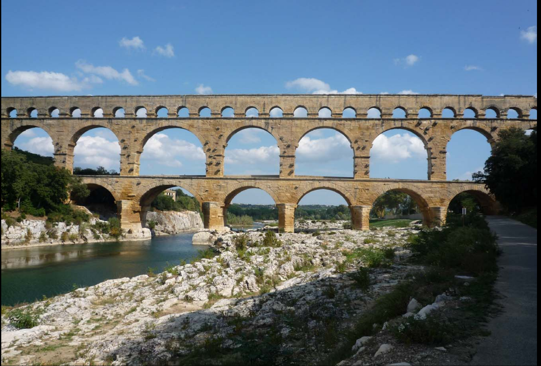
Pont du Gard (Francia)
